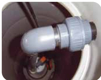
Refolement PVC 32 mm Traversée de paroi
