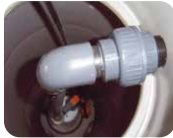
Refolement PVC 32 mm Traversée de paroi
